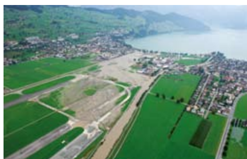
Überschwemmung vom 23. August 2005
